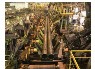
加工・精整された製品(パイプ)を自動結束機にて結束しています。
